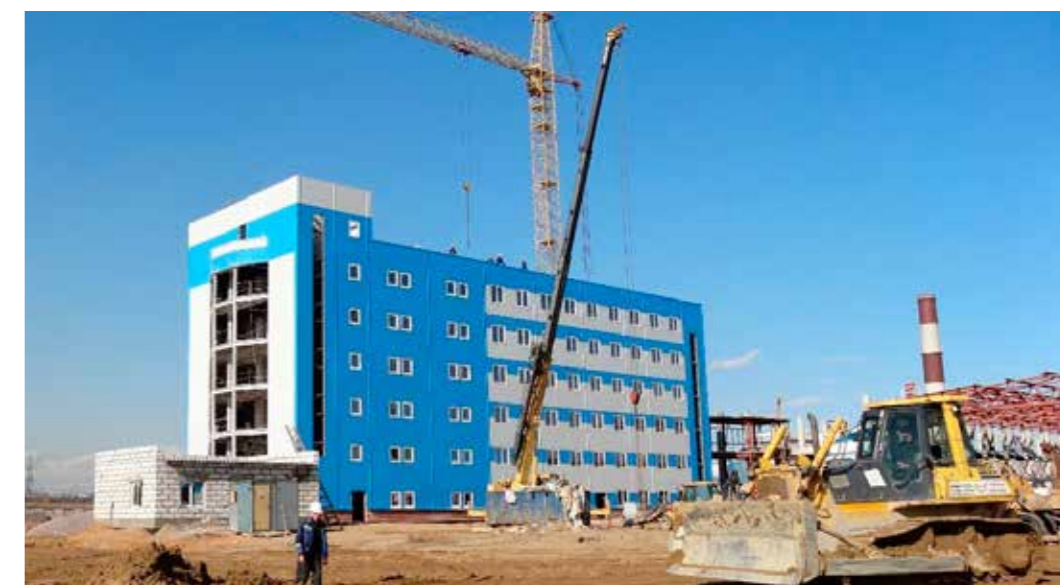
Ход строительства электродепо «Южное», апрель 2016 год
