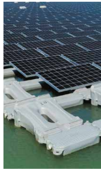
На плавучей солнечной электростанции установлены более девяти тысяч солнечных батарей. Они располагаются на специальной платформе из полиэтилена повышенной плотности общей площадью около 25 тысяч квадратных метров
