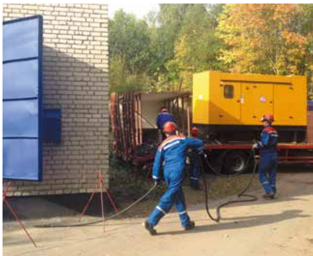
На подстанции 110 кВ № 195 «Тепличный комбинат» отключился трансформатор, в результате чего произошло ослабление схемы электроснабжения «Пулково», а также перестали работать светофоры на станциях метро «Проспект Ветеранов» и «Ленинский проспект». Бригада филиала «Ленэнерго» «Кабельная сеть» отправилась на место, чтобы подключить резервный источник снабжения электроэнергией к блочной трансформаторной подстанции № 4726 и обеспечить резервным питанием социально значимые объекты.
